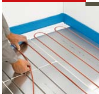
A fűtőkábelek fektetése
