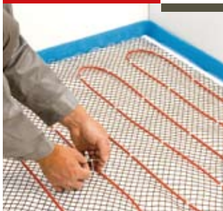
Fűtőkábel rögzítése
