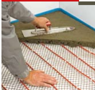
Esztrich-beton réteg felhordása
