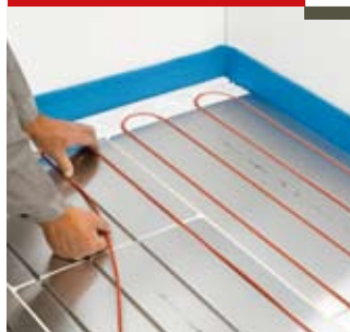
A fűtőkábelek fektetése
