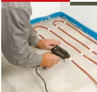
Fűtőkábel rögzítése
