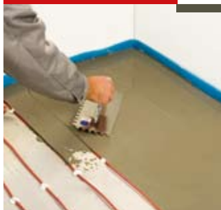
Kiegyenlítő réteg felhordása
