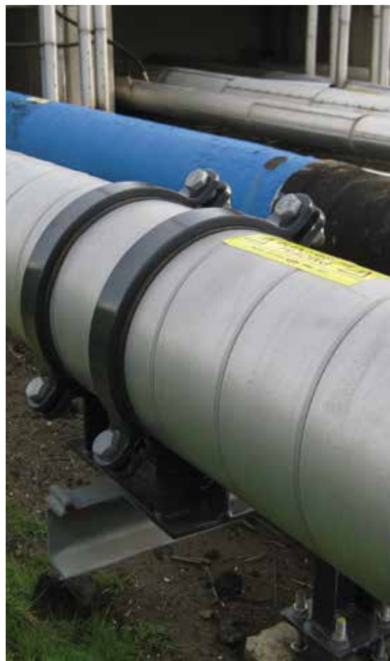
A burkolatra szerelt csőtartó garantálja az egységes hőprofil a csővezeték teljes hosszában.
